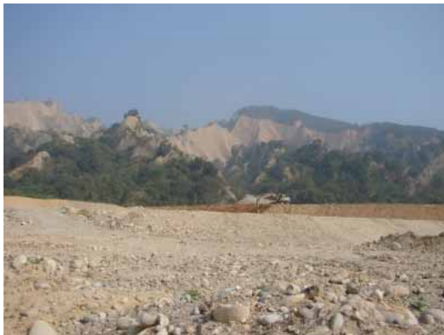
圖 14. 火炎山明隧道鄰近區域 地質災害整治不易。
