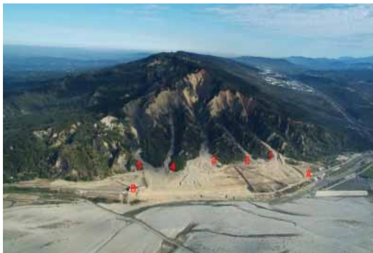
圖 18. 苗栗三義火炎山保留區之聯合沖積扇以及 130 甲中苗六線火炎山明隧道地理位置圖（A-B；山麓石頭河之小沖積扇 1-5，組成大的聯合沖積扇）。
