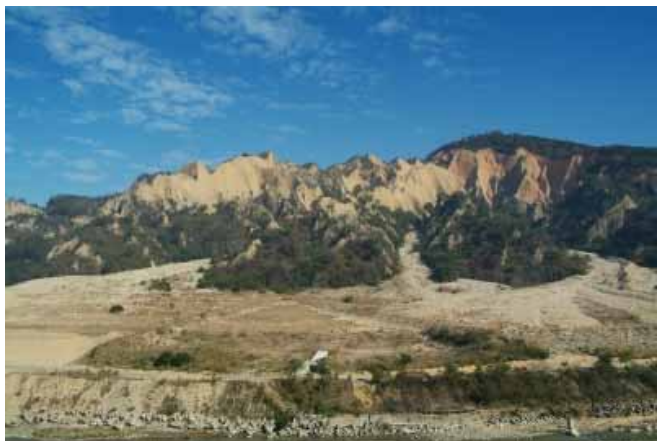
圖 12. 火炎山地質災害全貌。
