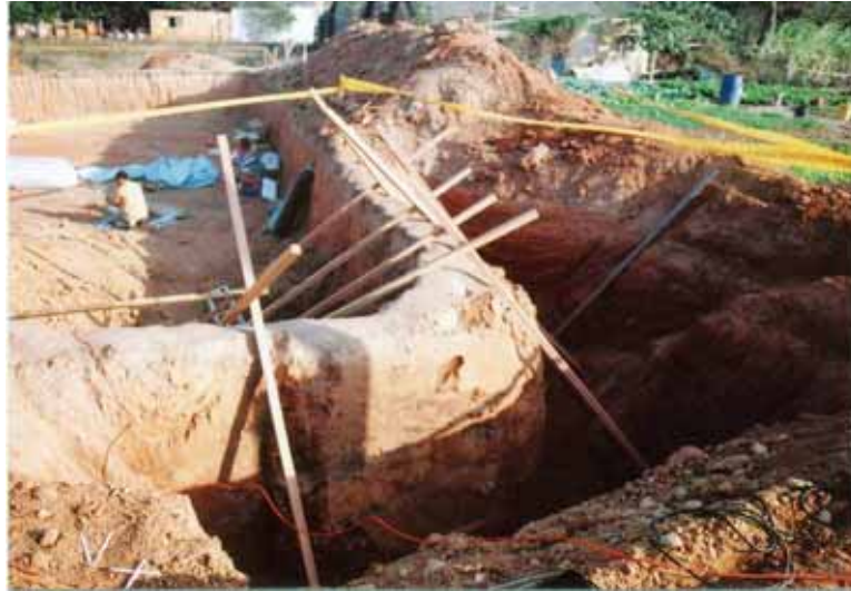
圖 11. 斷面雙側角材支撐加固。
