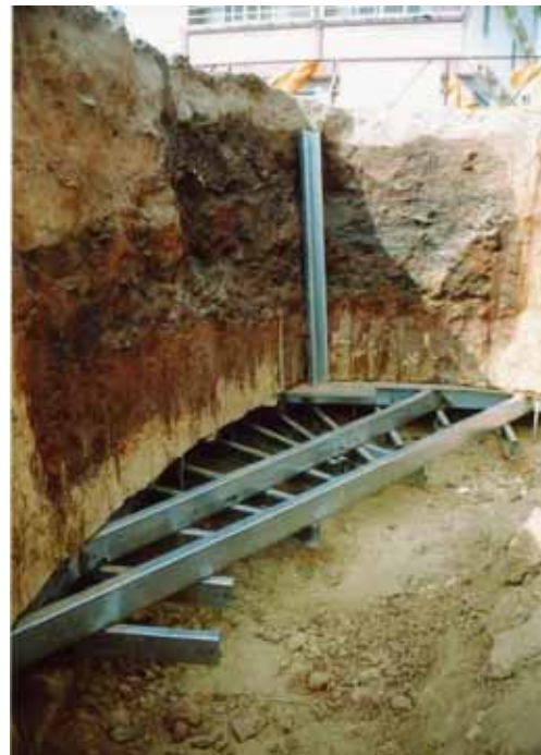
圖 10. 製作 C 型鋼架底座（二）。
