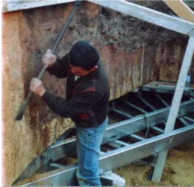
圖 8. 斷面雙側表面加固作業。
