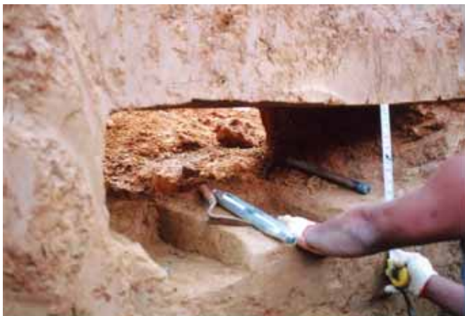
圖 4. 支撐架及底座鐵板製作（一）。
