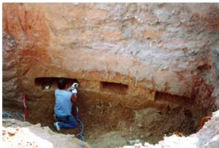
圖 6. 斷面底部掏空及支撐架、底座鐵板固定(一)。
