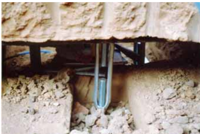
圖 5. 支撐架及底座鐵板製作（二）。
