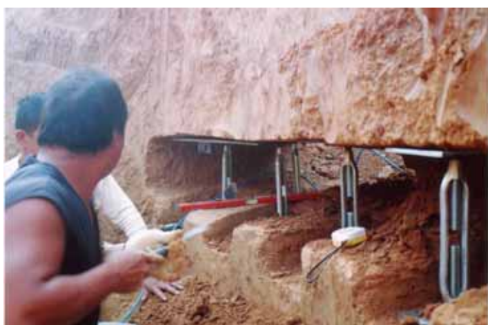
圖 7. 斷面底部掏空及支撐架、底座鐵板固定(二)。
