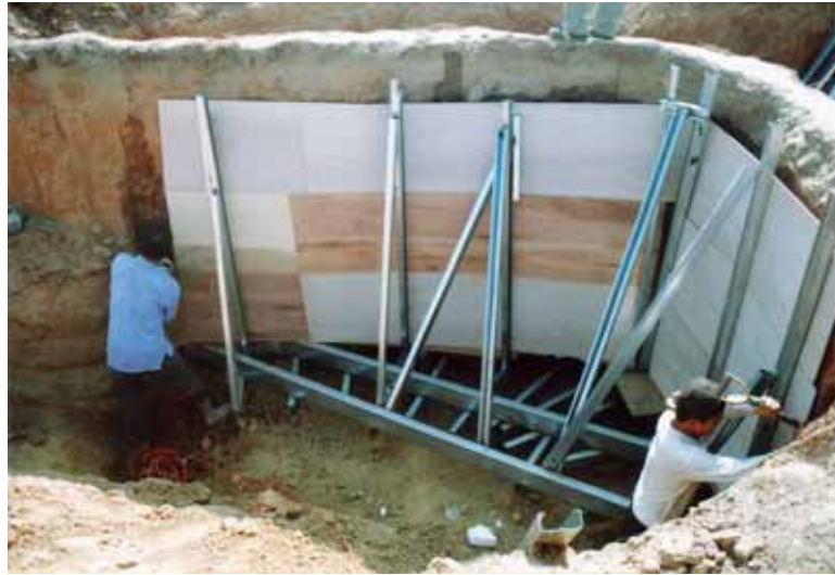
圖 13. 基礎封裝及斷面兩側掏空（二）。
