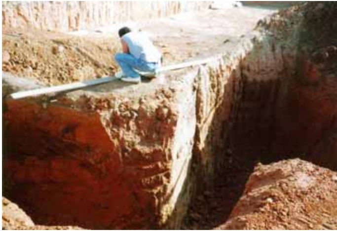
圖 3. 斷面雙側工作通道挖掘（二）。
