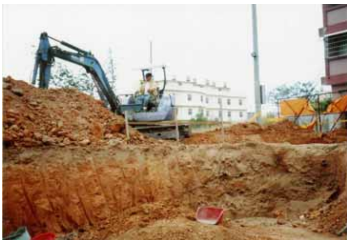
圖 2. 斷面雙側工作通道挖掘(一)。
