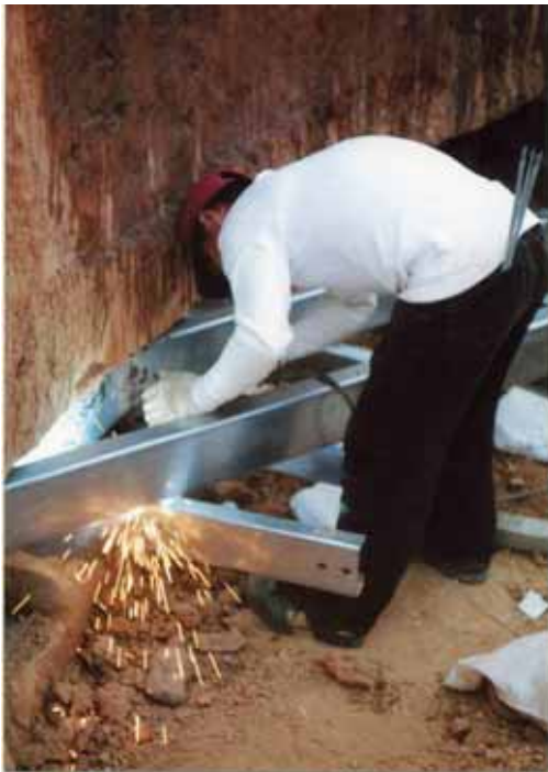
圖 9. 製作 C 型鋼架底座（一）。
