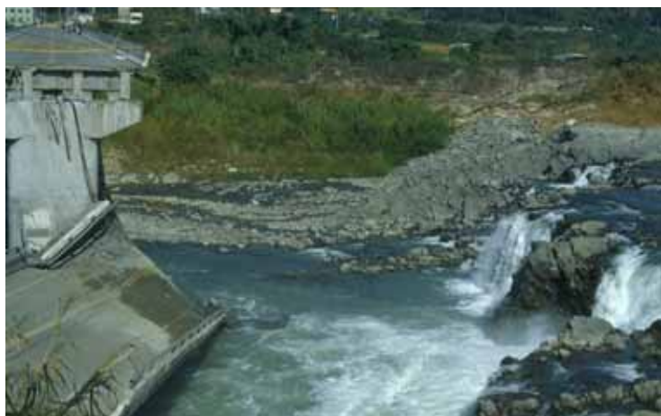
圖 3. 埤豐瀑布。921 地震車籠埔斷層地表破裂造成埤豐橋毀壞，大甲溪河床埤豐瀑布誕生。
