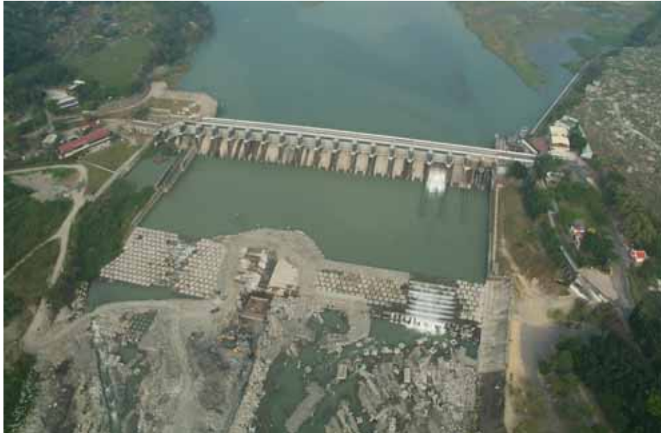
圖 1. 石岡水壩。921 地震毀壞南側閘門後經修復之石岡壩空照圖。
