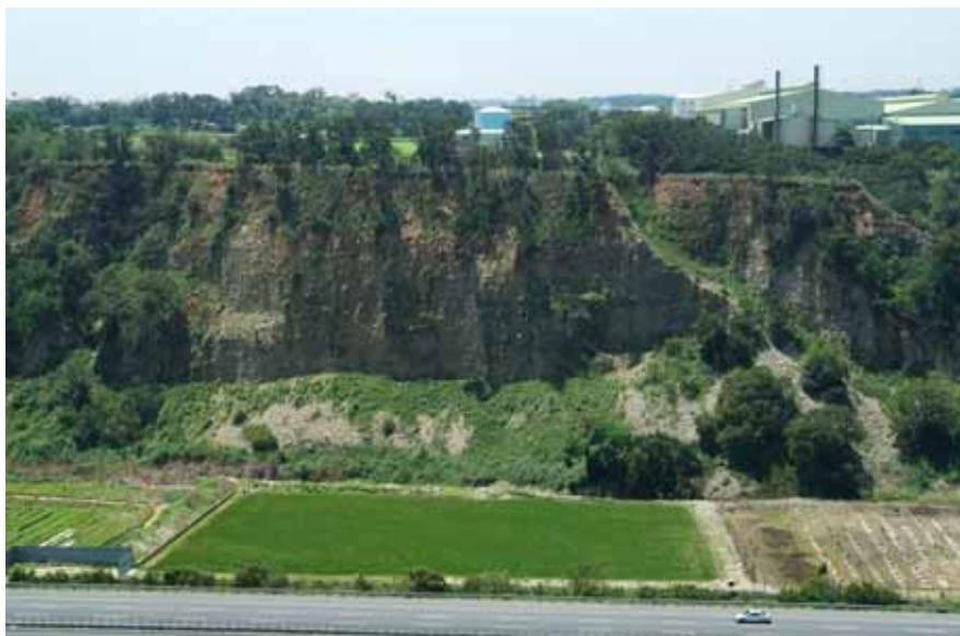
圖 10. 大甲溪大肚山臺地外緣頭嵙山層不當開挖易坍塌邊坡，沖刷土石危及大甲溪流暢。
