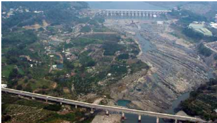
圖 6. 石岡水壩—埤豐橋間大甲溪河床新地貌
