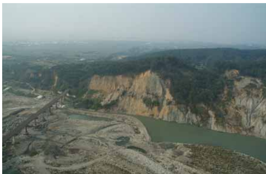
圖 8. 大甲溪豐原頂角潭段(后豐鐵馬道——大甲溪橋)三義斷層舊址整治後現況
