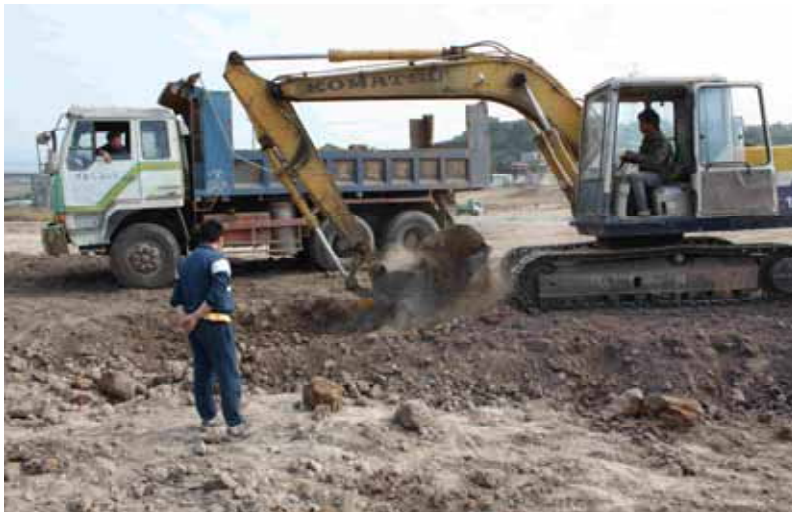
圖 1. 挖土機在牛埔遺址上開挖
