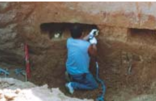
圖3.底部掏空及支撐架、底座鐵板固定
