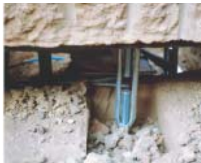
圖2.架及底座鐵板製作
