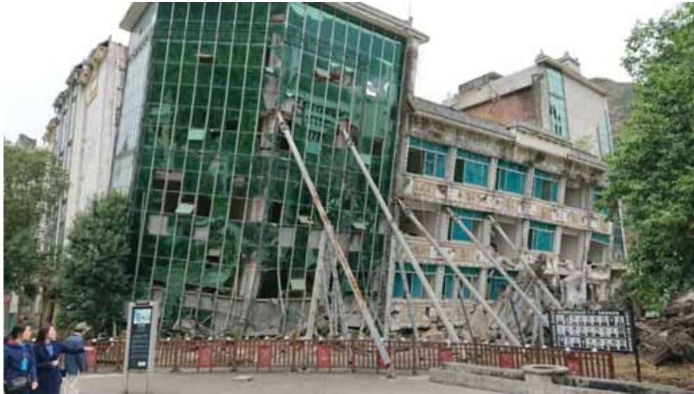
圖 2. 利用鋼柱被動支撐，防止震毀建物倒塌。
