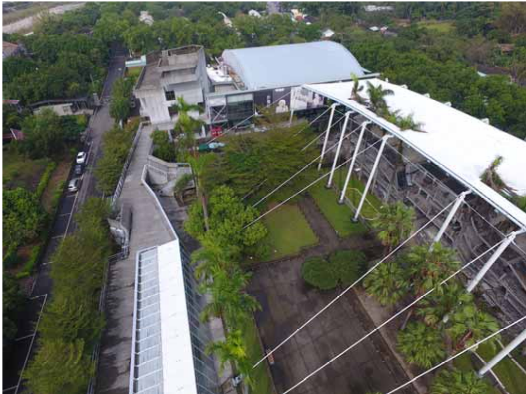
圖 3. 921 地震教育園區利用鋼柱與鋼索構成的巨大頂篷，作為北棟毀壞教室的遮蔽，避免風雨直接侵襲。
