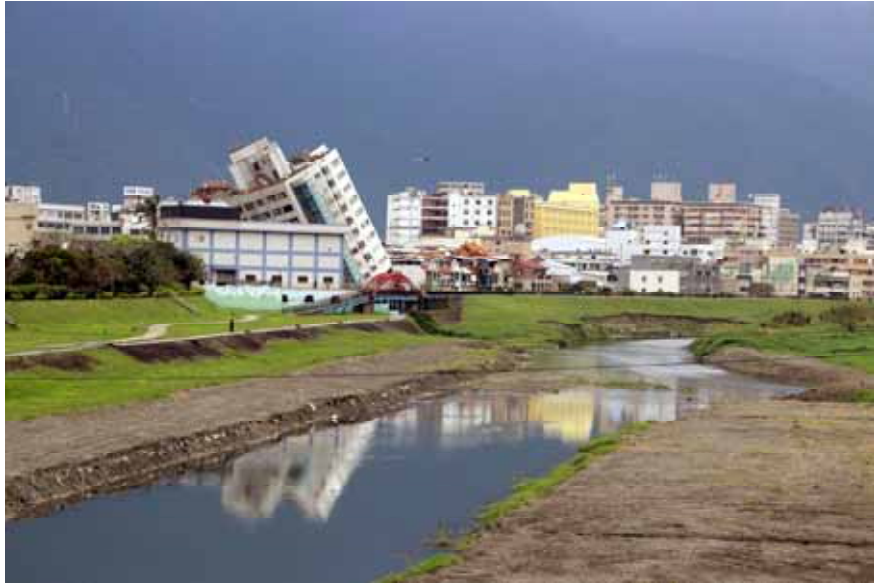
圖 1. 本次花蓮地震造成雲門翠堤大樓的傾斜倒塌
