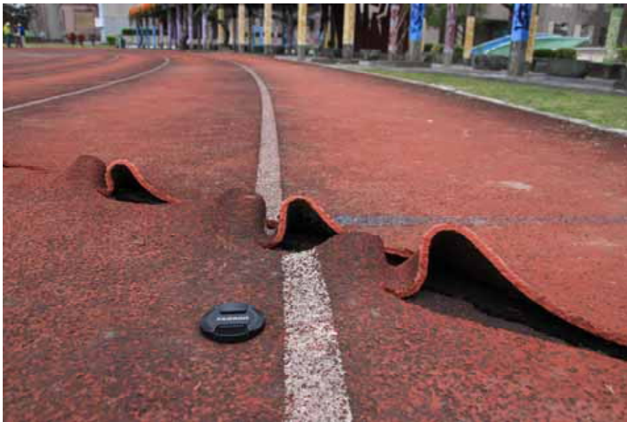
圖 2. 花蓮地震在東華大學創新研究園區操場所產生的水平左移錯動，位移約 6 公分。
