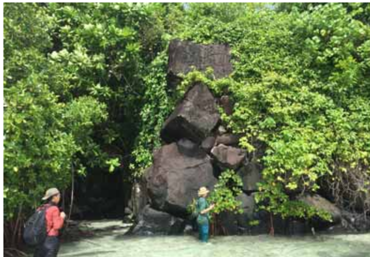
圖 6. 最西南邊的人工島西南角。可能因為這裡是所有人工島西側的最外圍，所以此處的玄武岩塊是最巨大的，高度也是王陵以外最高的，以抵抗海浪。
