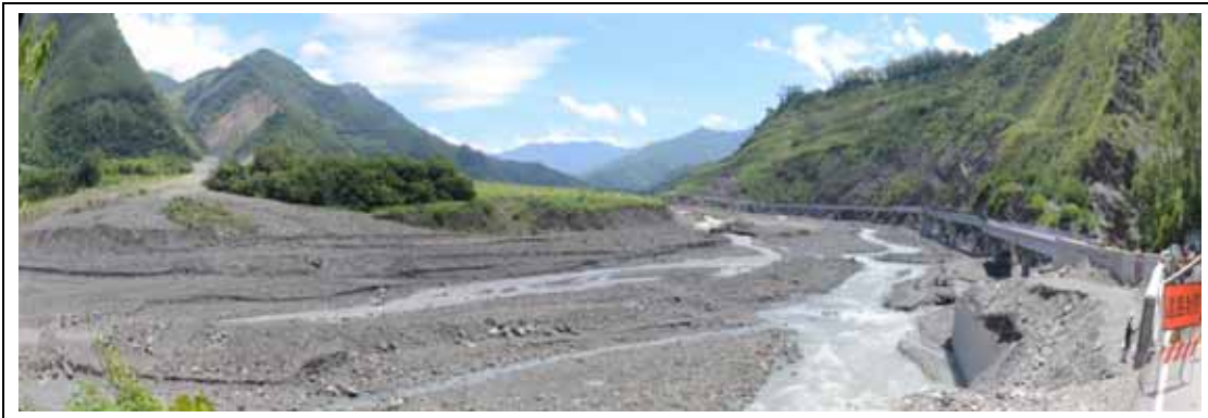
圖 6 左側布唐布那斯溪帶來巨量的沉積物，在與荖濃溪的交會口堆積形成大型沖積扇，曾一度堵住河道形成堰塞湖。經人工開挖整治，現堰塞湖雖已消失，但整個荖濃溪流路還是偏向右側。原本建在右側的南橫公路早已崩毀，新高架公路緊靠右側山壁。今年四月底剛通車，在六月初的梅雨季，部分路段再次遭洪水沖壞。
