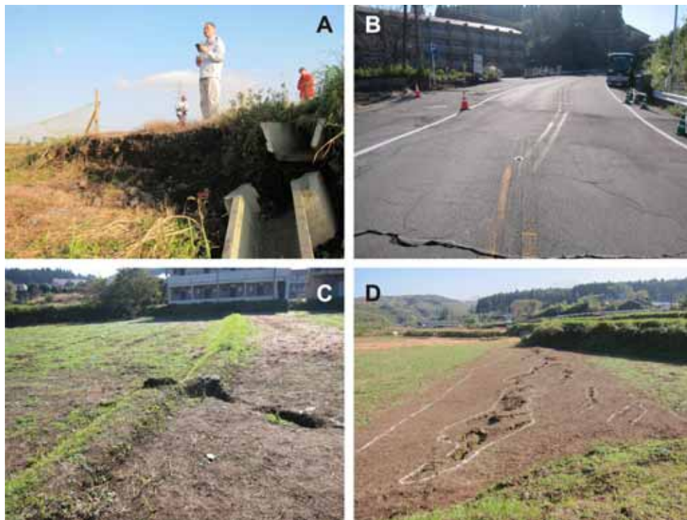
圖3. (a)位在阿蘇火山群東南的阿蘇西國小附近，農地被斷層抬高約一公尺。(b)東海大學阿蘇校區附近道路。雖然路面已經修補，但是雙黃線仍然記錄著斷層右移的現象。(c)長陽西部國小附近的田埂斷層右移約一公尺。(d)長陽西部國小附近農田中有雁型排列的斷層破壞(白色為用石灰粉標記)。
