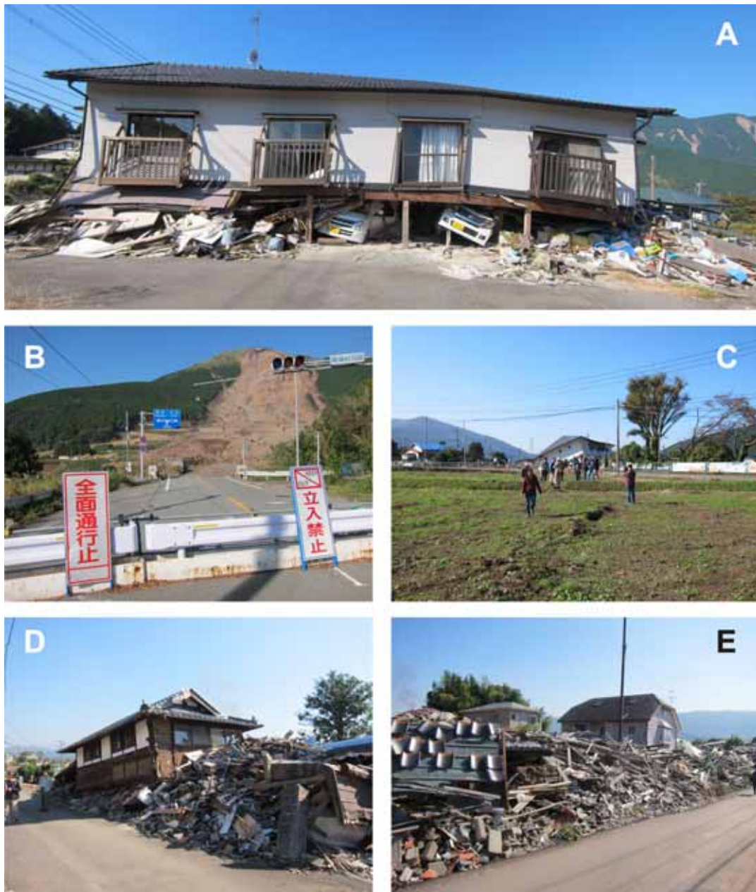
圖4. 熊本地震在南阿蘇村造成嚴重破壞。(a)房屋垂直坍塌壓毀停放在一樓的車輛。(b)地震引發大規模山崩與泥石流，也將1971年所建的主要聯外道路阿蘇大橋摧毀。(c)斷層線穿過的地方房屋倒塌。(d)與(e)為主震震央附近益城町的房屋破壞情況。
