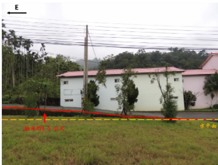
圖 4. 竹山園區周圍的地變斜坡小路。原本近乎平坦的道路，集集地震後路面相對抬升 1.5 公尺，重鋪柏油後成為如今的坡路(箭頭處)。
