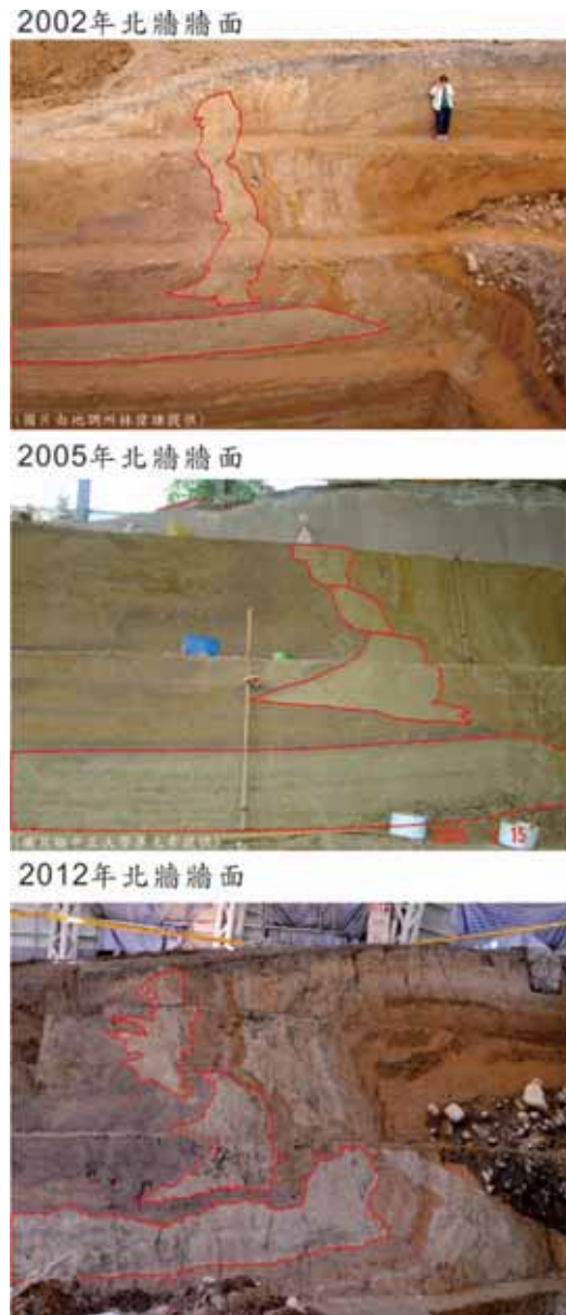
圖 2. 歷年北牆的構造變化。紅色框線所示意的為原本連續的同一土層單元。此土層單元在不同時期的擴挖牆面上，逐漸變成數個不連續的斷塊。
