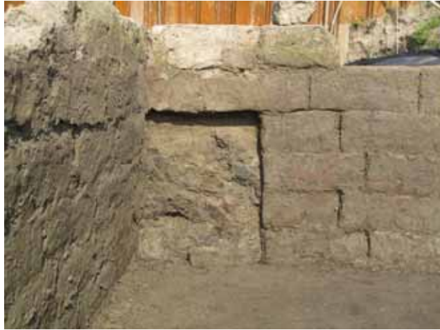
圖 2. 被封住的排煙口
