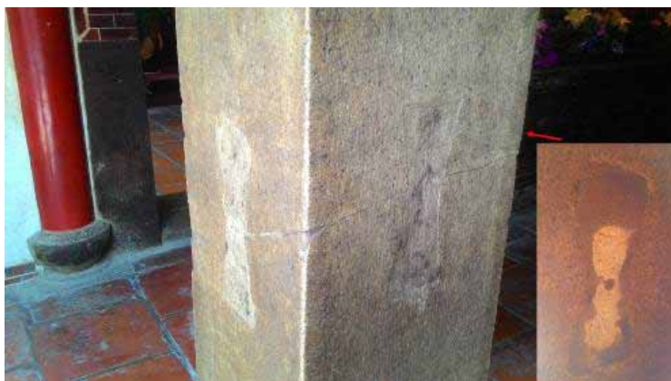
圖 6. 嘉義縣新港鄉奉天宮後殿因 1906 年梅山地震受損裂開，後由重建師傅打釘穩固（右下圖為柱後打釘圖）。
