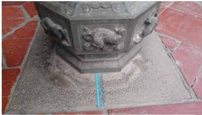
圖 7. 龍山寺龍柱位移的痕跡，可推測此龍柱經歷多次地震而移位。
