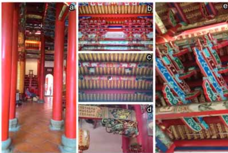
圖 6. a 元清觀為全臺首先使用增柱法之廟宇。b 象頭拱。c 樑上的大象彩繪。d 鰲龍雀替。e 螭龍斗拱。
