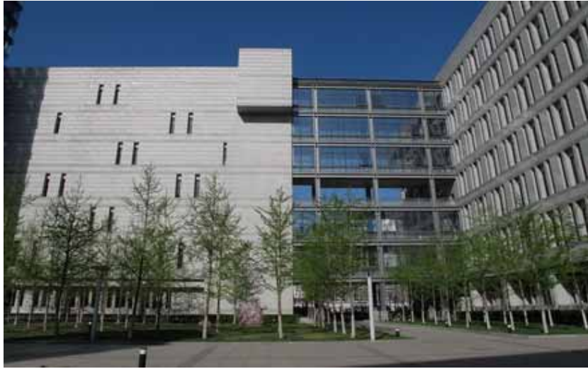
圖 2. 標本館(左邊白色建築)與右方的研究大樓以空橋相連
