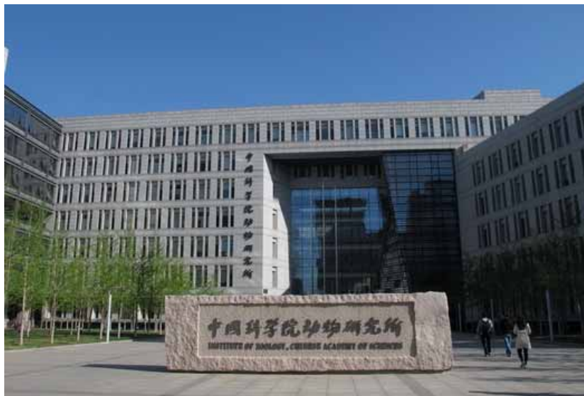
圖1. 中國科學院動物研究所大樓，標本館在圖左側。
