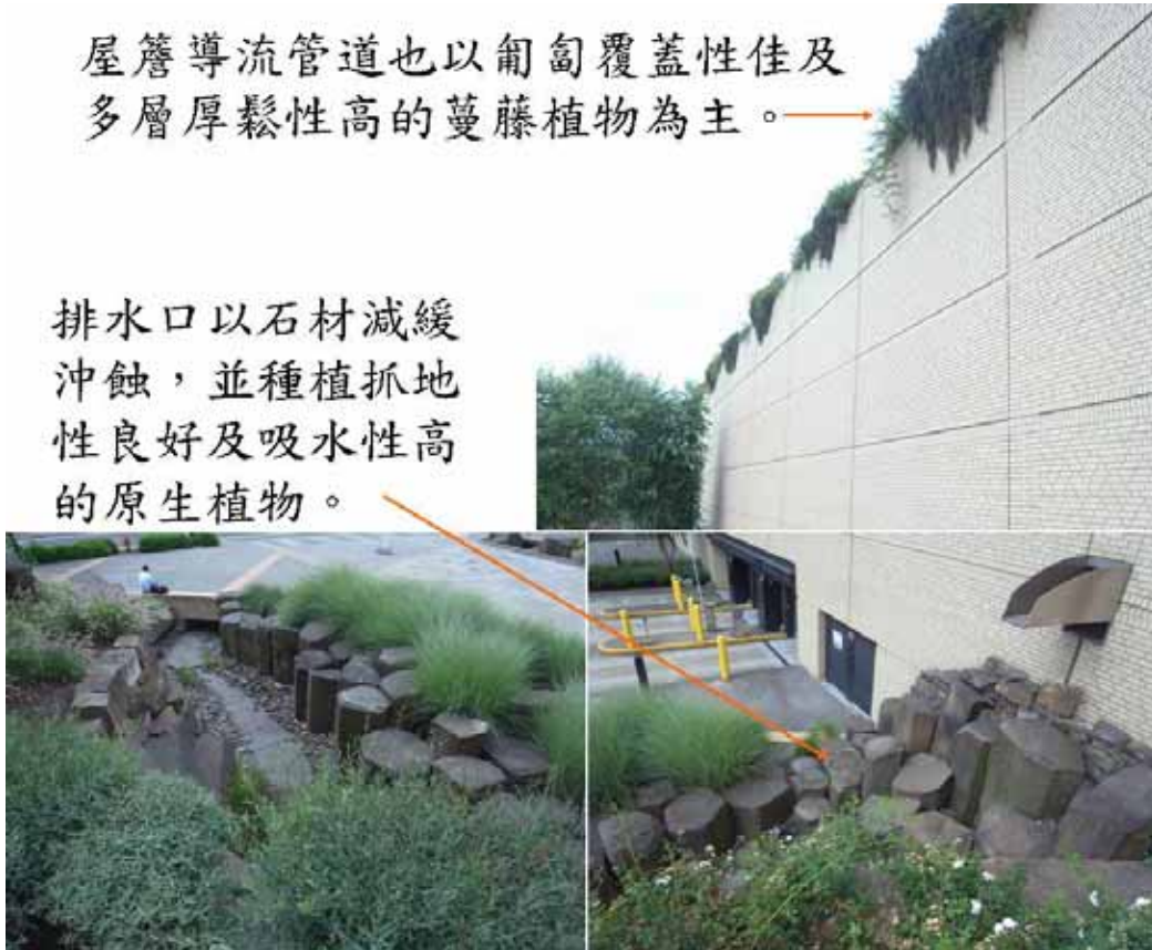
圖 3. 雨花園的匍匐蔓藤屋簷及礫石石材排水口。
