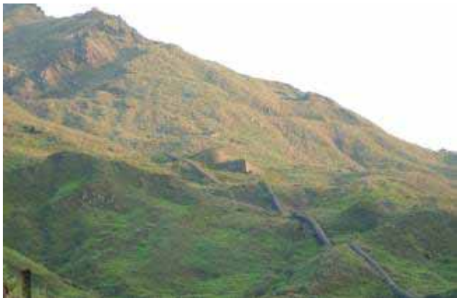
圖 10. 金瓜石廢棄煉銅廠當 時為解決空氣汙染所 建的排毒煙管殘留
