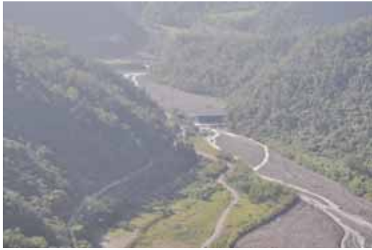
圖 3. 寒溪番社坑溪上游攔沙壩
