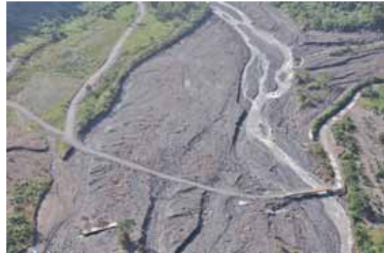
圖 4. 寒溪古魯林道多崩塌地
