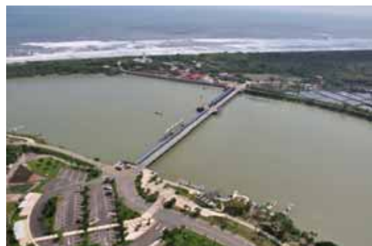
圖 17. 冬山河地區地勢低窪每逢大雨，尤其颱風豪雨，為防海水倒灌設有防潮大閘門。
