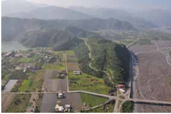
圖 7. 冬山鄉鼻子頭鼻頭橋梅花湖入口圓環，於芭瑪颱風過後溪流河床多漂流木。
