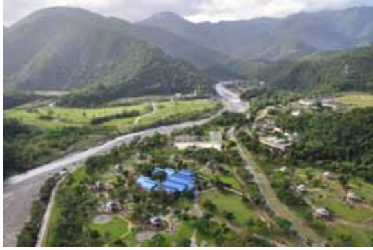
圖 26. 新城溪支流武荖坑溪上游攔砂壩及武荖坑風景區
