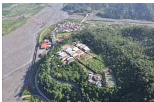
圖 2. 寒溪村新光巷泰雅部落簡易自來水廠。
