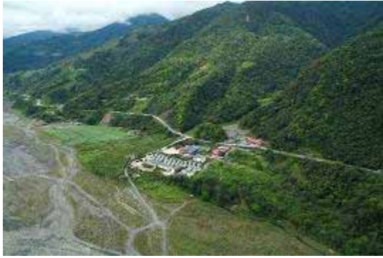
圖 15. 英士村英士山莊，因位於無名溪小支流匯入蘭陽溪交會口崩塌地與小沖積扇址部，與石頭橋同為具潛在性危險之建築體。
