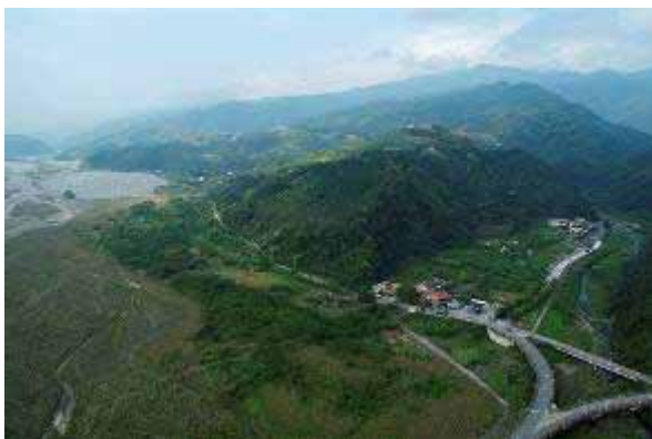
圖 5. 大同鄉崙埤村破礮溪(九寮溪)空照圖
