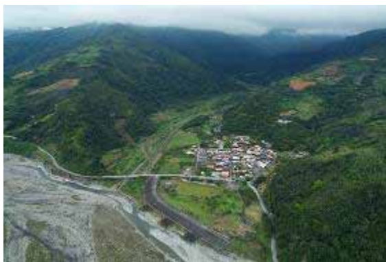
圖 11. 松蘿村、松蘿溪與松蘿橋。
