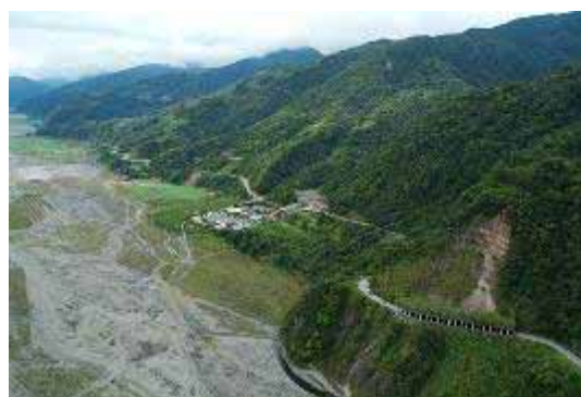
圖 13. 蘭陽溪溪畔英士山莊—明隧道
