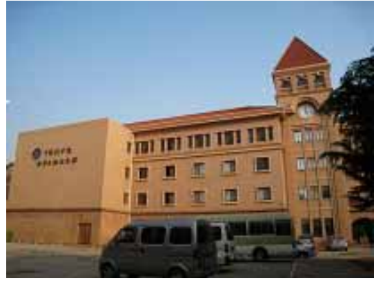
圖 4. 中科院海研所的海洋生物標本館特殊的鐘樓形建築
