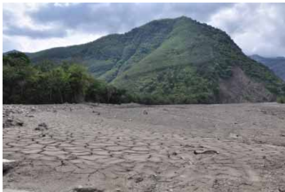
圖 18. 堰塞湖潰堤後河床曬乾之泥裂
