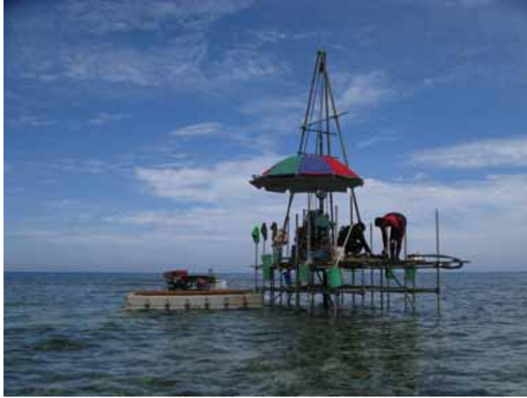
圖 3. 在礁臺上搭建鷹架，鑽探工作可以不受漲潮的影響。
