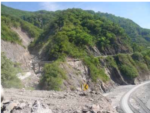
圖 17. 八八水災時桃源舊社高賢橋遭洪水沖毀，沿線所經為劈理發育的樟山層硬頁岩地層。
