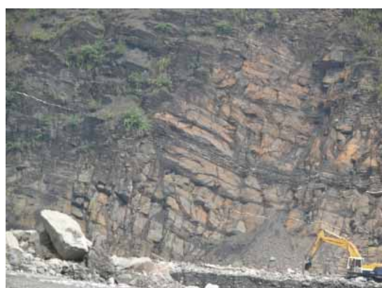
圖 5. 桃源區高中里綠茂河岸為長枝坑層中砂頁岩薄互層，河床土石堆積嚴重，必須經常清除，以維護南橫公路暢通。
