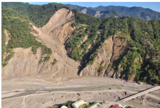
圖 1. 荖濃溪寶來二號橋周遭地景，位處於寶來彎曲攻擊坡，因邊坡不穩定容易山崩滑移。
