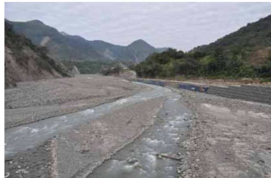
圖 26. 勤和少年溪鄰近地區，荖濃溪右岸災後利用貨櫃與蛇籠築堤，規範行水河道，搶修道路之狀況。
