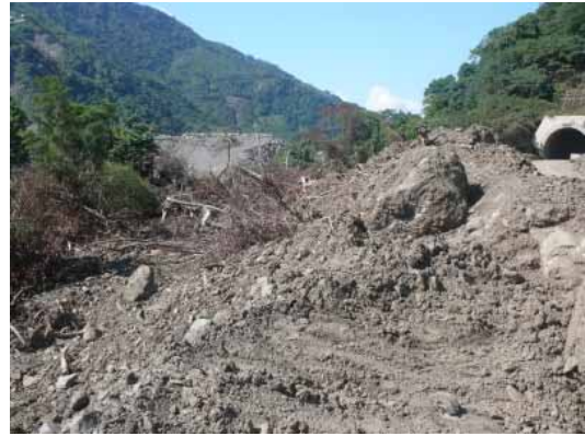
圖 16. 塔拉拉魯芙隧道口土石流破壞的情景
