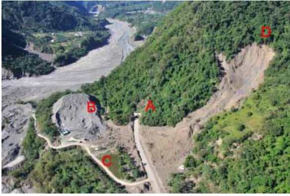
圖 15. 塔拉拉魯芙隧道口。A 為東側隧道口；B 為南橫公路北側棄土場；C 為通往明隧道目前已禁止通行之舊公路；D 為西側崩塌地。
