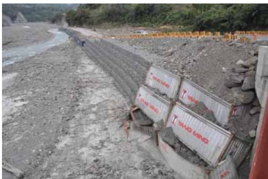
圖 25. 荖濃溪勤和—桃源間的南橫公路現況圖，莫拉克颱風災後，利用蛇籠貨櫃搶修通車之概況。
