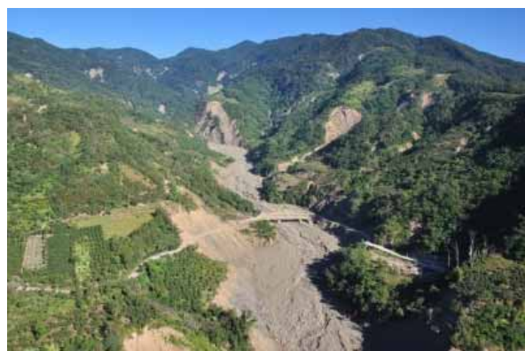
圖 10. 高中二村與大肚關之間的新翠谷橋周遭地貌（此塔羅留溪向下匯注至荖濃溪）。塔羅留溪兩岸崩塌嚴重，環境復育困難重重。
