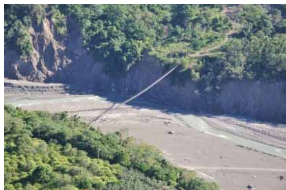
圖 3. 六龜囉囉埔鉅鹿吊橋已斷落頹掛於溪邊懸崖，荖濃溪沿岸大水沖刷土石崩塌，光禿一片。
