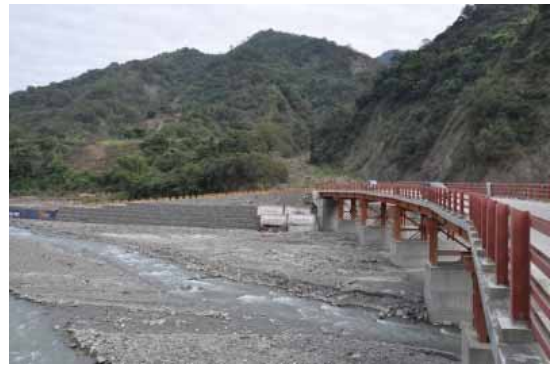
圖 24. 桃源至勤和間之樂農橋於八八水災後設立地標為臨時便道 1K，荖濃溪兩側以蛇籠貨櫃堆置架設臨時通路。
